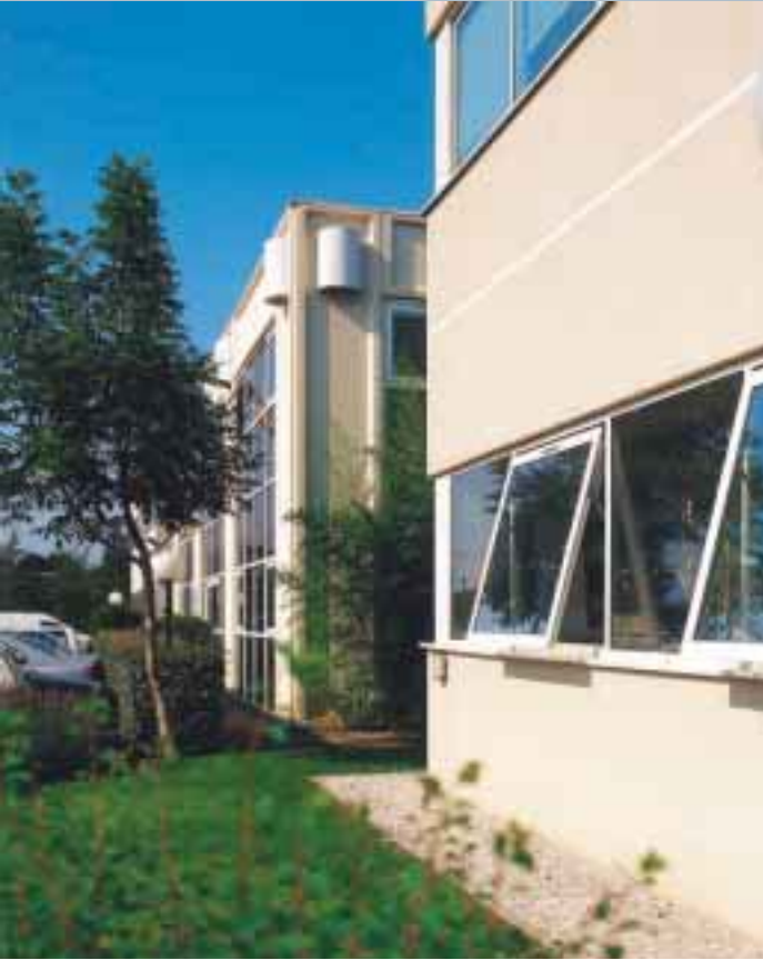
Architecte : Chardet et Huet - Photographe : X. Boymond
